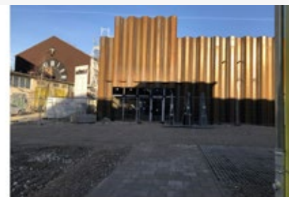
Die Uhr auf dem Bestandsgebäude steht auf 5 vor 12. Daneben leuchtet das neue Schwere Reiter | © Christiane Pfau
