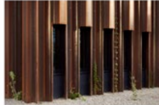
Im Falle eines Hochbaus stellen die Spundwände einfach wieder aus dem Boden röhren, die Dächer werden entfernt werden. Foto: Oliver Jäsi
