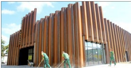
Markante Fassade aus Spundwänden: Die letzten Vorbereitungen für die Eröffnung laufen. Foto: Stäbler
