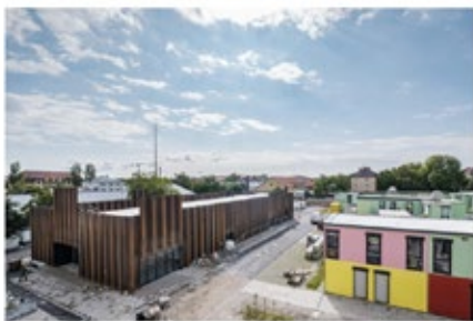
Der Neubau zwischen Bestandsbauten und Containerstadt, Foto: Franz Kimmel
